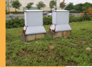
變電箱旁的蟻丘
